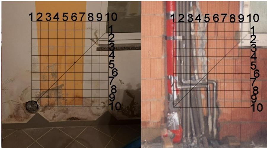
Mit diesem Bild konnte der Rohrbruch leichter gefunden werden. Das 3. Rohr von links Zirkulation war undicht. Die Kästchen haben 10x10cm. In diesem Fall wurde der Deckel und das Fenster für den Maßstab hergenommen.
