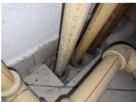
Bei Rohren die senkrecht in den Estrich verlegt werden, eine Abdichtung mit Brunnenschaum machen.
